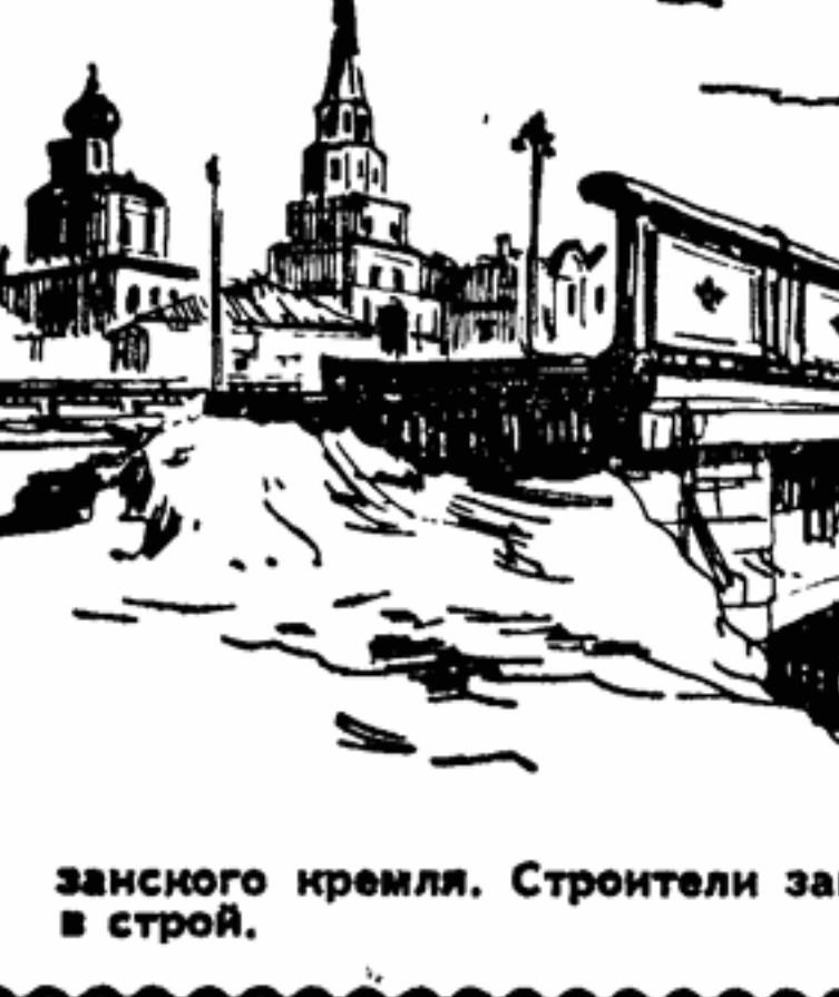
Занесено кремни. Строители завершают отделочные работы; мост скоро вступит в строй.
